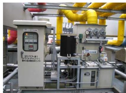
酸性ガス用排ガス浄化装置
