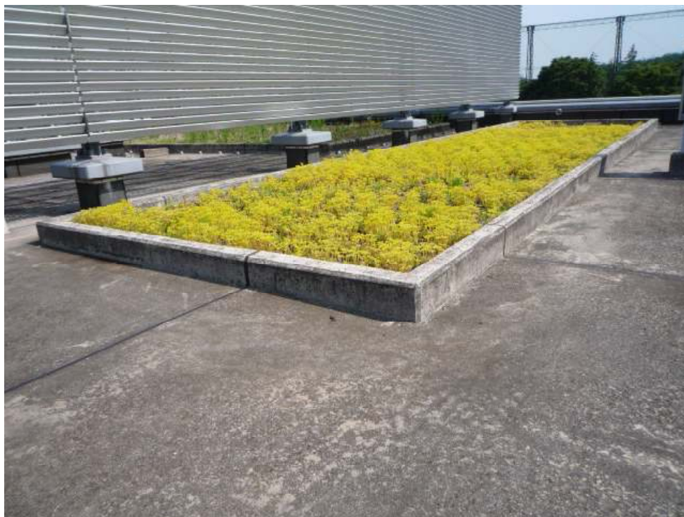
小平庁舎の屋上緑化
