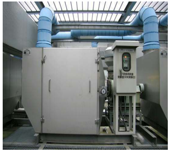
活性炭式脱臭装置 (乾式スクラバー)
