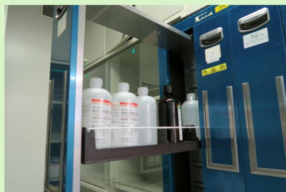
薬品保管庫内部
