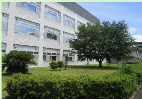
小平庁舎敷地内
