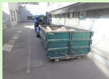
収集・運搬作業
